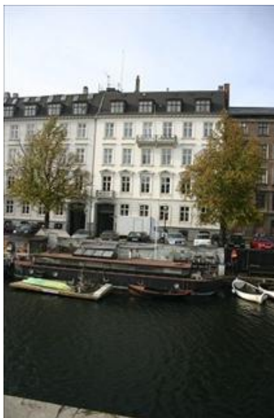
Frederiksholms Kanal 16 er det første københavnske hus med facade i italiensk renæssancestil og blev tegnet af HC Stilling.
