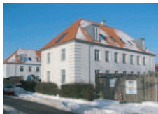
Indretning af taglejligheder og ny tagkonstruktion
