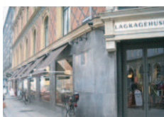
Ombygning af butikslokaler til bageri
